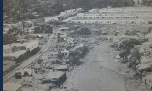
Deslizamiento La Zompopera, Chalatenango, activado en 1998..
